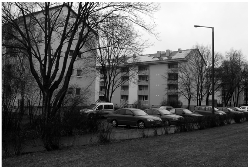
Abbildung 6.5: Mit Fotovoltaikanlage ausgestattete Süddachfläche in der Zollerstraße
