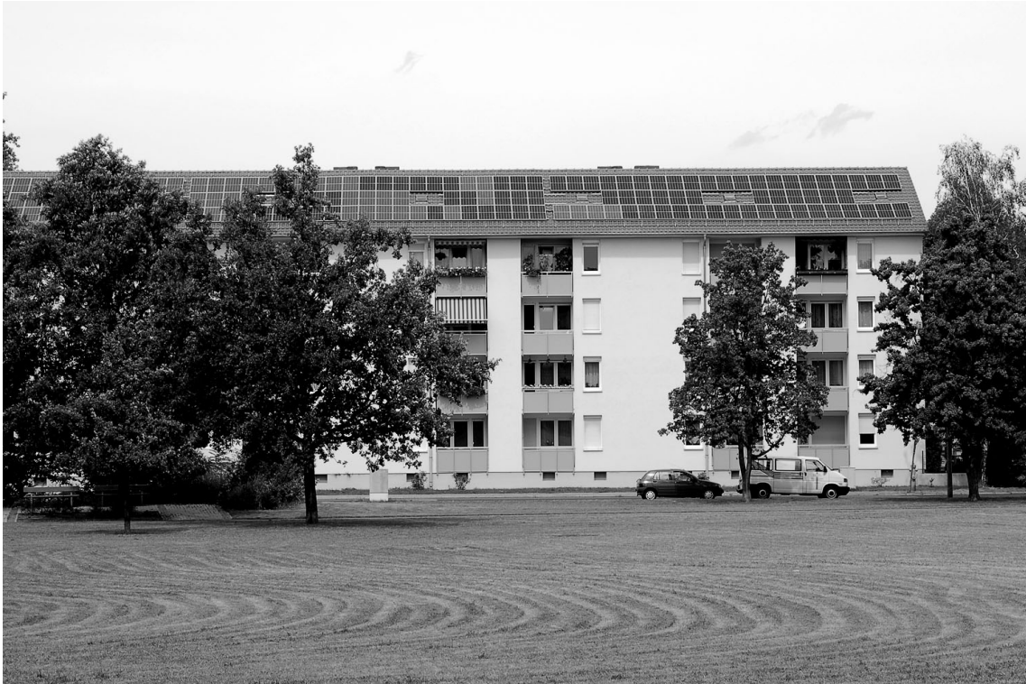
Abbildung 2.28: Sanierte 1950er Jahre Siedlung mit Fotovoltaikanlage, Leopoldstraße.
