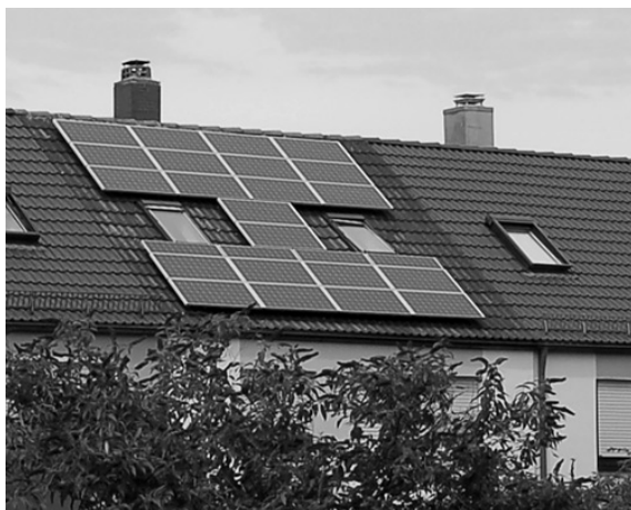
Abbildung 2.25: Integration einer Fotovoltaikanlage in das Satteldach eines Reihenhauses, Konstanzenstraße
