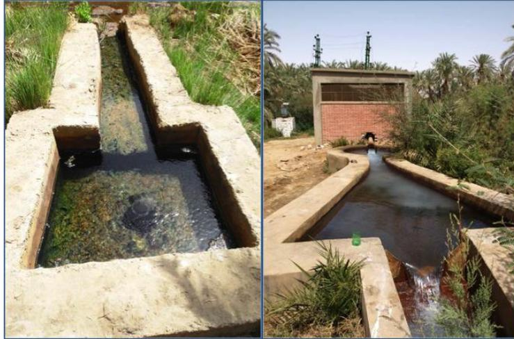
**Abbildung 12: Brunnensysteme in Bahariya.** Links: Sammelbecken eines traditionellen unterirdischen Kanalsystems (Foto: Hudribusch (2010)), Rechts: Auffangbecken eines Regierungsbrunnen (*abâr hukumiyya*) mit geöffnetem Schütz (Foto: Mayer (2010))
